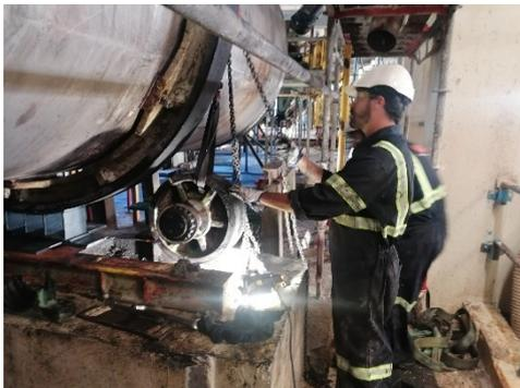
Fig. 2 – Substituição dos roletes
