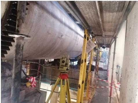
Fig. 4 – Alinhamento dos roletes a partir da linha de centro do secador
